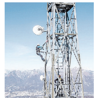
L'OPERAZIONE di installazione del ponte radio a Col Faverghera
